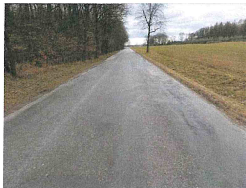
Ztráta makrotextury, mozaikové trhliny
