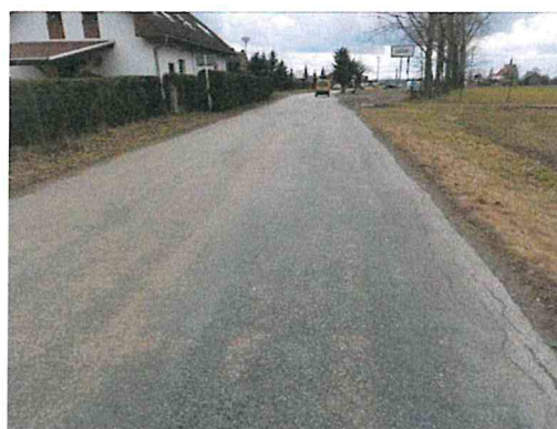
Ztráta makrotextury, olamování okrajů vozovky
