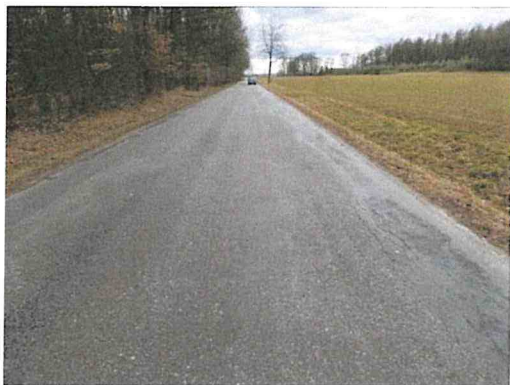
Ztráta makrotextury, mozaikové trhliny
