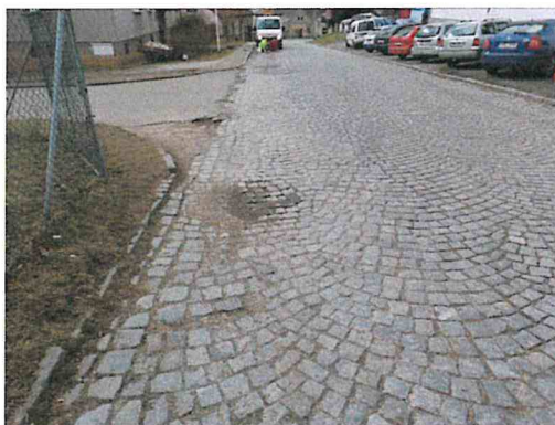
Plošná deformace vozovky
