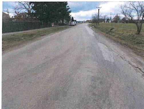
Mozaikové trhliny, olamování okrajů vozovky
